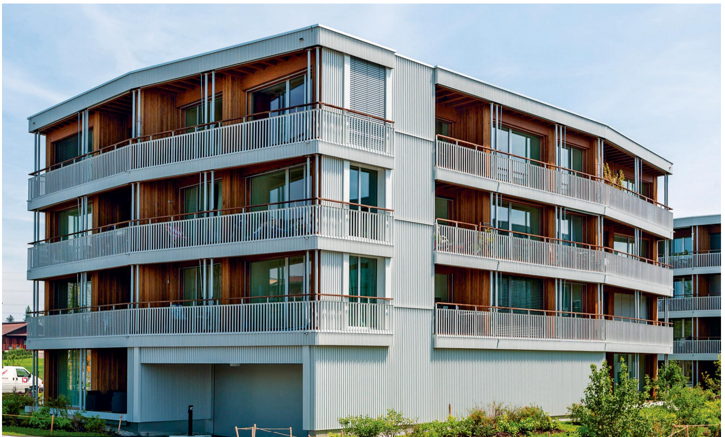
Mehrgeschossiger Holzbau mit Holz-Beton-Verbund-Decken
